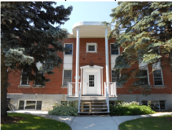
Nouvelle façade en briques – juin 2015
